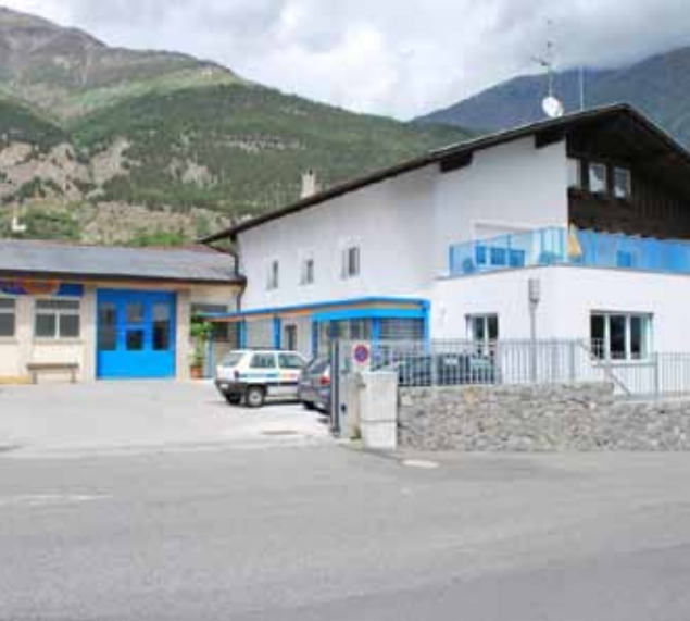
Verwaltungsgebäude des E-Werkes und Zivilschutzzentrum
